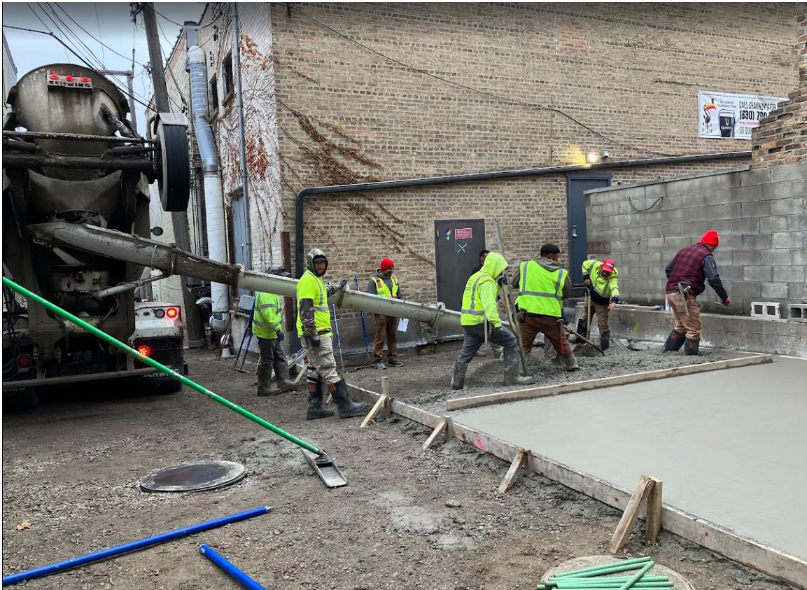
Duane-Main Alley concrete pour
